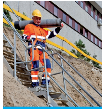
Bezpieczne zejście do wykopu.
