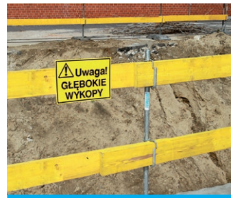
Zabezpieczenie krawędzi wykopu.
