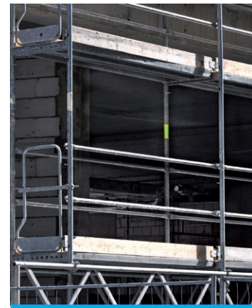
Balustrady ochronne od szczytu rusztowania.
