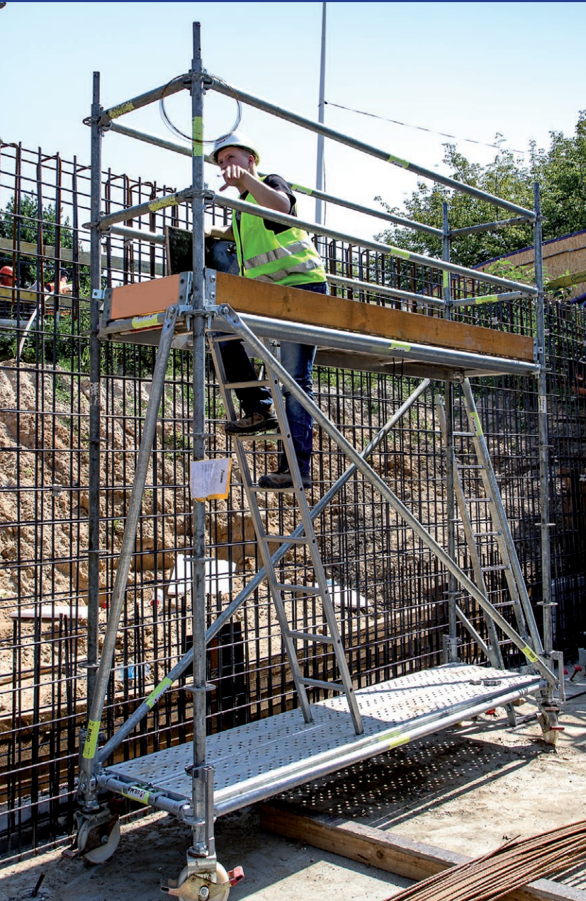
Hamulec rusztowania przejezdnego.
